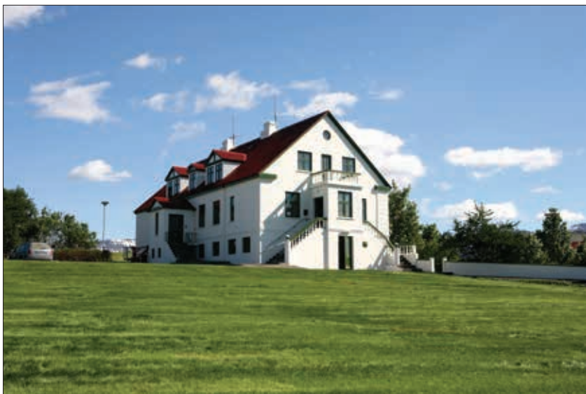
Íbúðarhúsið (skólastjóraráhúsið á Hvanneyri, 1920). Veittið athygli gerð húshornanna. Var Guðjón húsameistari þar að líka eftir torfbæjarvegg?
