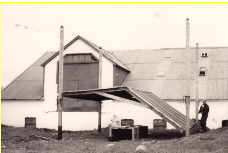
1. mynd: Heyturninn í smíðum austan við Tilraunahlöðurnar og „Bygginguna“ á Hvanneyri, sem svo var jafnan kölluð. Búið að koma súlum fyrir og smíða þakið, því hefur verið lyft vinstra megin. Leiðistokkurinn fyrir súgþurrkunarloftið inn að miðju turnsins er kominn á sinn stað.
