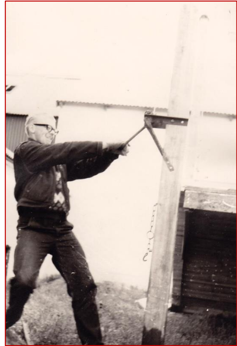
3. mynd: Tilraunamaðurinn og skýrsluskrifarinn, Bjarni Guðmundsson, lyftir þaki turnsins með handspili. Það var hvorki auðvelt né hættulaust, að hann hélt. Á súlunni hangir keðjulæsing spilsins.
